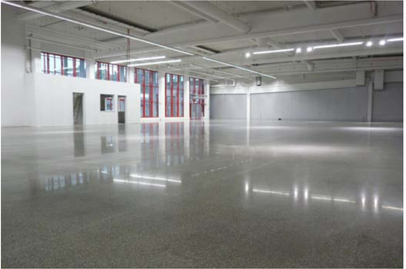
Geschliffener Industrieboden nach Applikation von OBTEGO R-400
