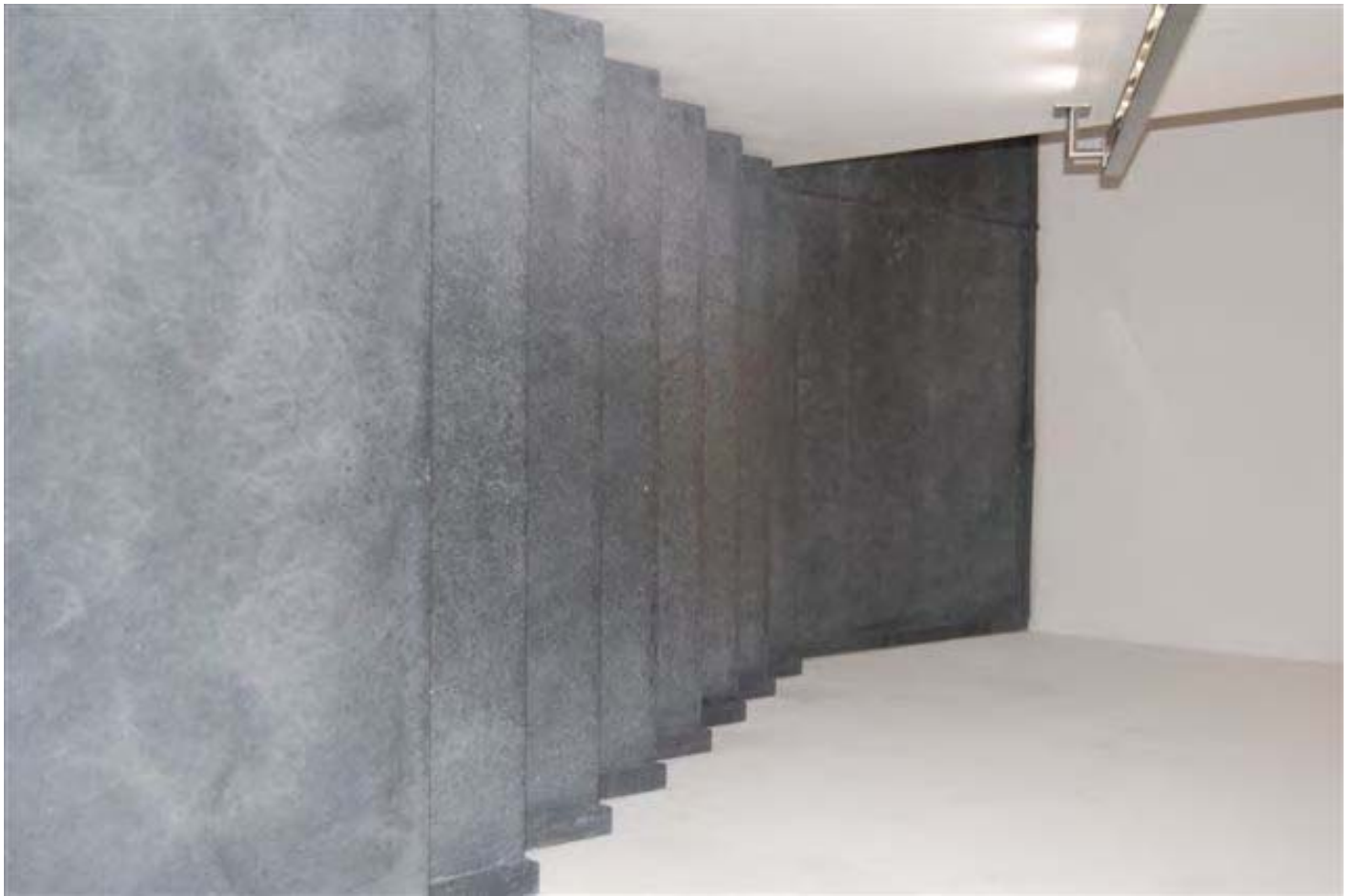
Treppenhaus; Terrazzo (anthrazit) mit Schleifwolken vor der Applikation von OBTEGO R-400
