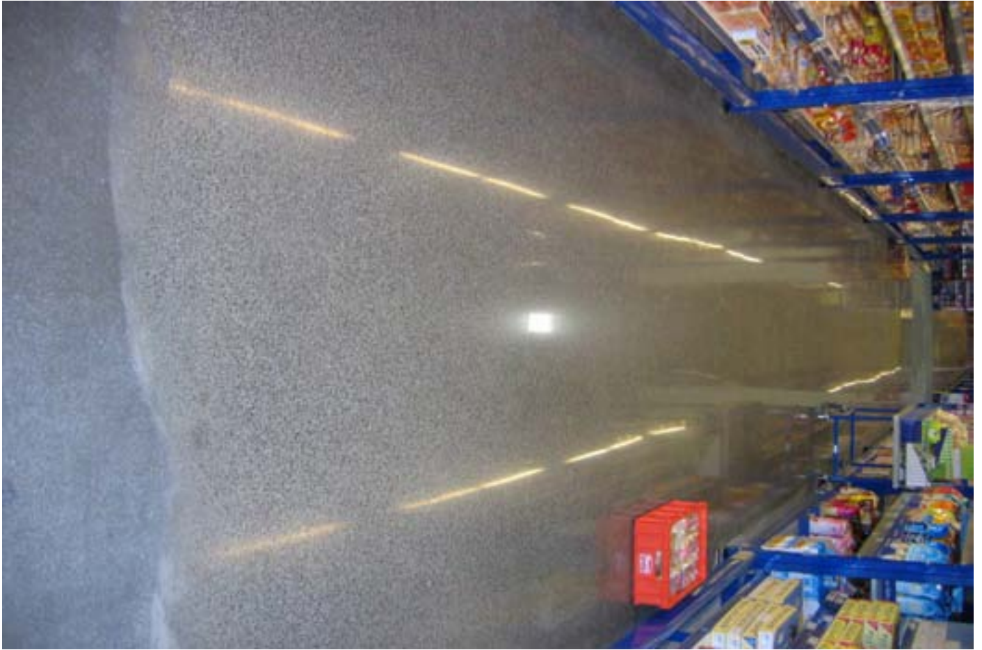
Bodensanierung und Applikation von OBTEGO R-400 Fleckschutz
