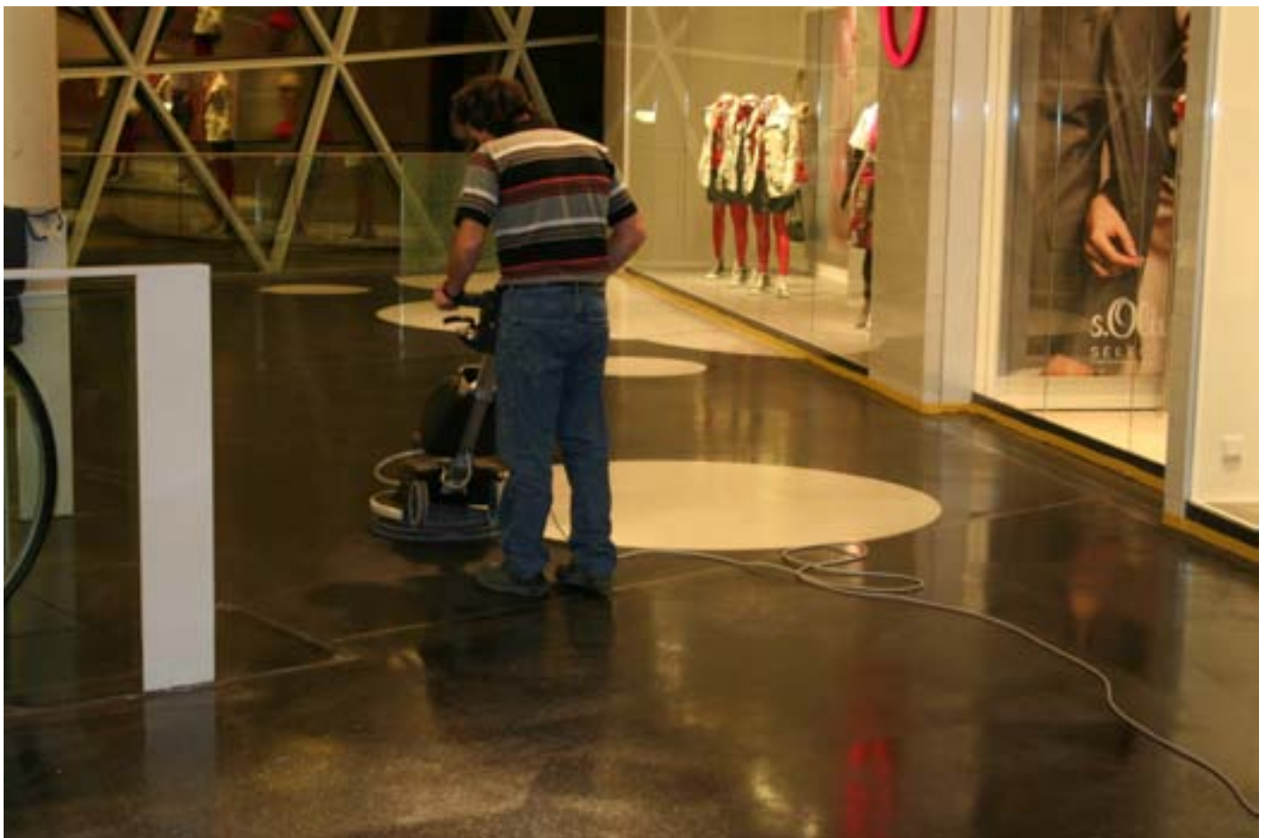
Einpolieren von OBTEGO R-400 in die Terrazzofläche um eine gleichmäßige Farbtonvertiefung zu bekommen.
