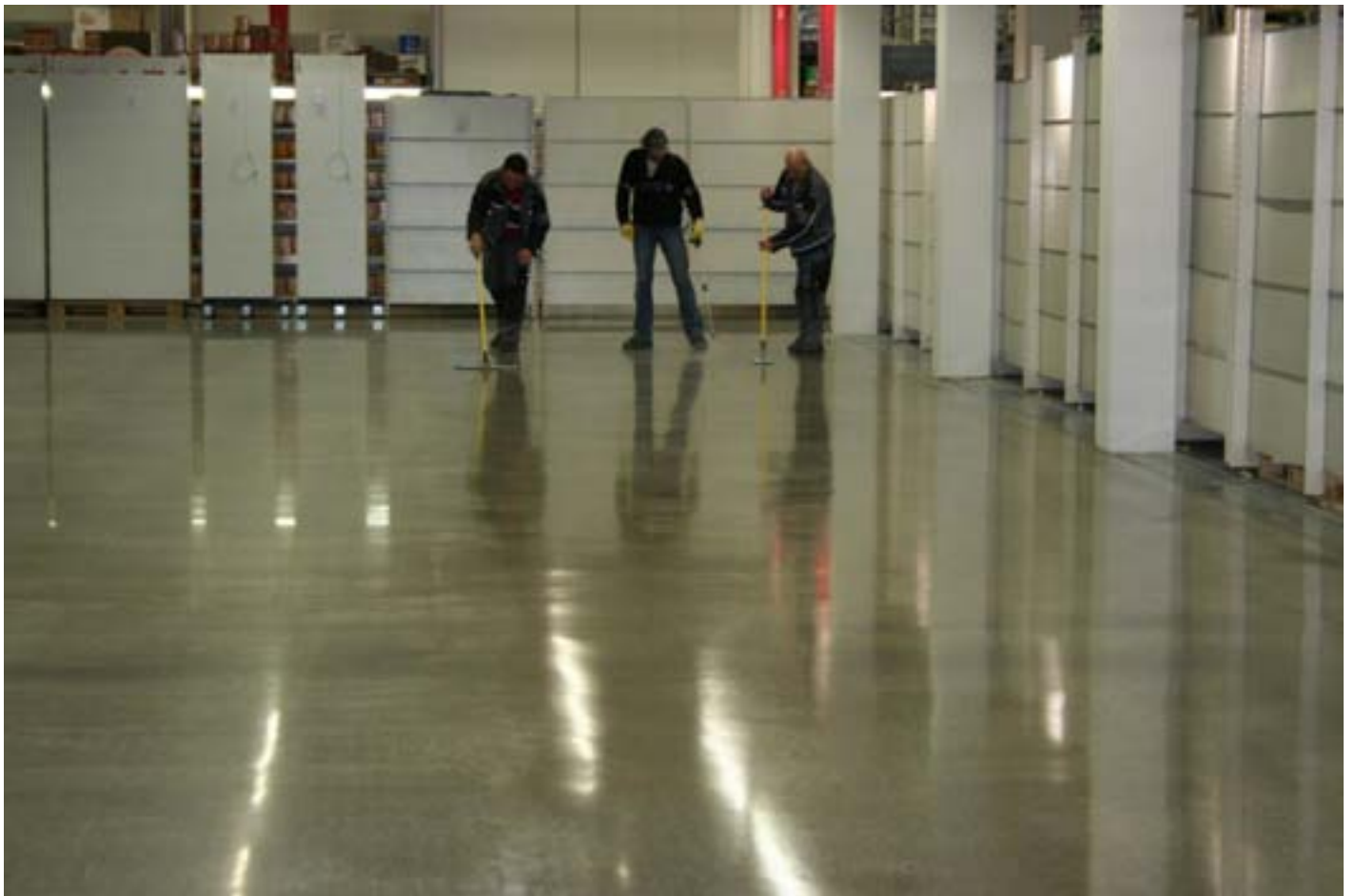
Applikation von OBTEGO R-400 auf einen geschliffenen Industrieboden. Bild 1
